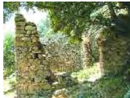
sul lato nord, nella facciata principale addossata alla roccia, è ancora presente traccia di falda di tetto, e comunque per la stessa sua posizione doveva essere necessariamente a falda unica.
